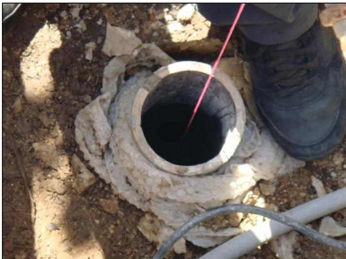
Dans le terrain de la fondation Camargo, à Cassis, se trouve le forage exécuté après positionnement à la balise magnétique, pour rejoindre la rivière de Bestouan.
