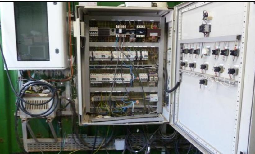
L'armoire électrique, point névralgique de l'éclairage, des communications et de l'alimentation des différents appareils (treuil, groupe électrogène..
