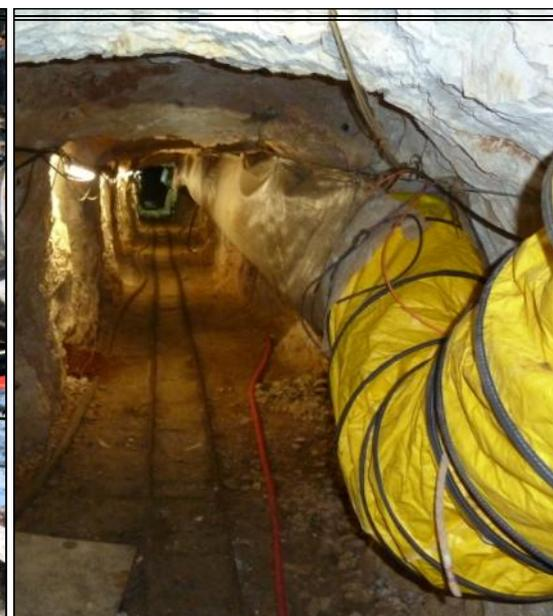
Réfection de l'éclairage de la galerie menant du puits au barrage et pose d'une gaine de ventilation.
