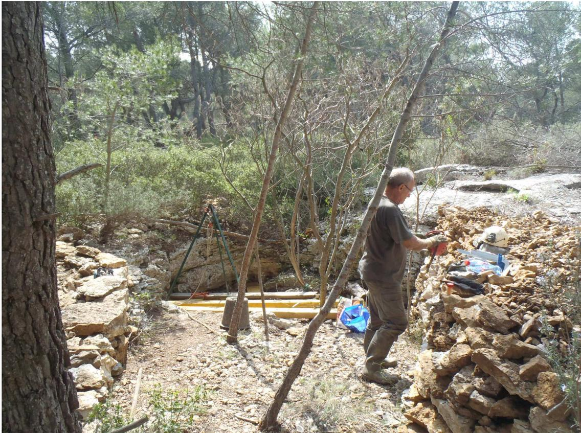
A partir du mois de mars, nous installons le dispositif définitif d'aménagement de la plateforme d'extraction en scellant au mortier les madriers et en fixant, provisoirement, la chèvre récupérée sur une cavité de la région toulonnaise où nous travaillons.
